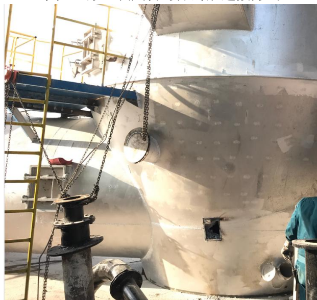
图 2 改造后三次风管与分解炉连接方式
