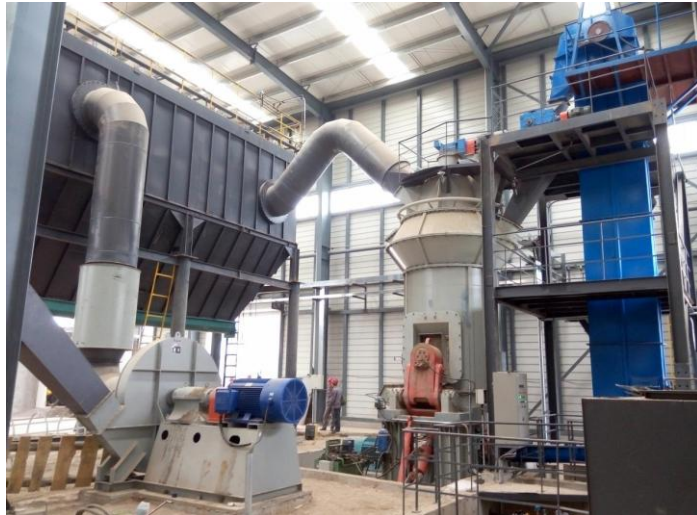
图 5-建筑垃圾立式磨应用现场
