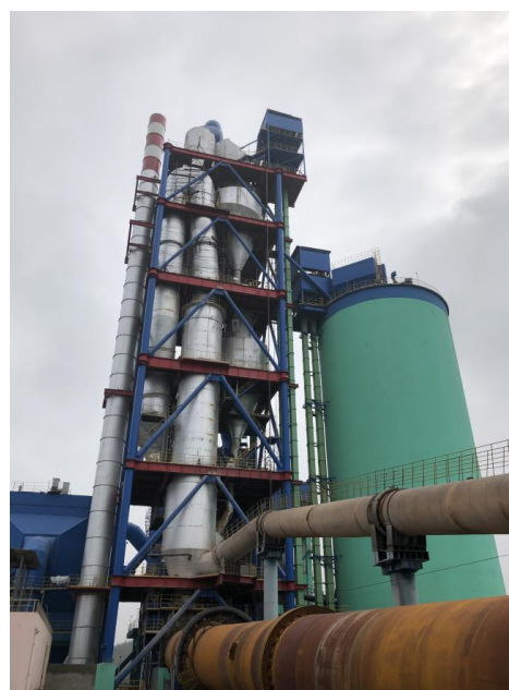
图 6 改造后窑尾预分解系统外型
